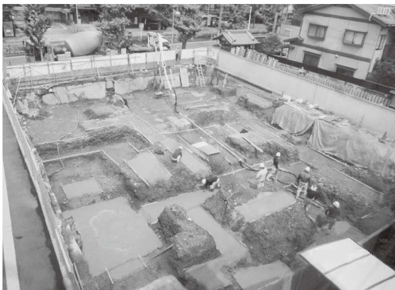
写真は6月下旬の基礎下地工事
